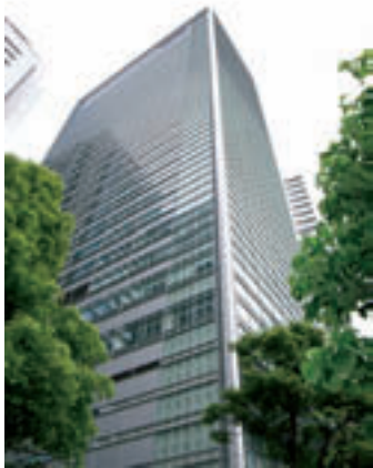
キヤノンマーケティングジャパン株式会社 外観
